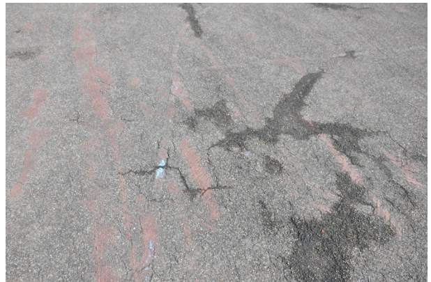
Belagsschäden Trockenplatz
