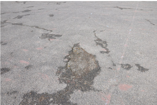
Belagsschäden Trockenplatz
