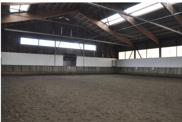
Reithalle mit Zuschauergalerie
