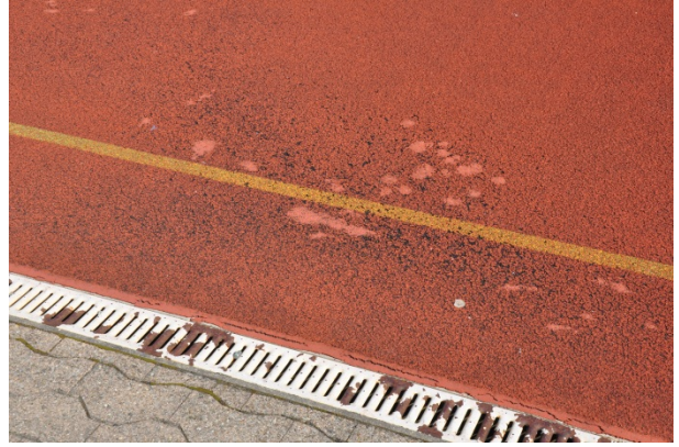
Belagsschäden Trockenplatz
