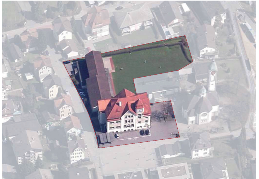
Die Schulanlage Haldenbüel (Hauptbau, Klassentrakt und Turnhalle) aus Westen; die zu erneuernden Bereiche sind hervorgehoben. Foto: Google-Maps, Bearbeitung: Baumschlagger Eberle St. Gallen AG
