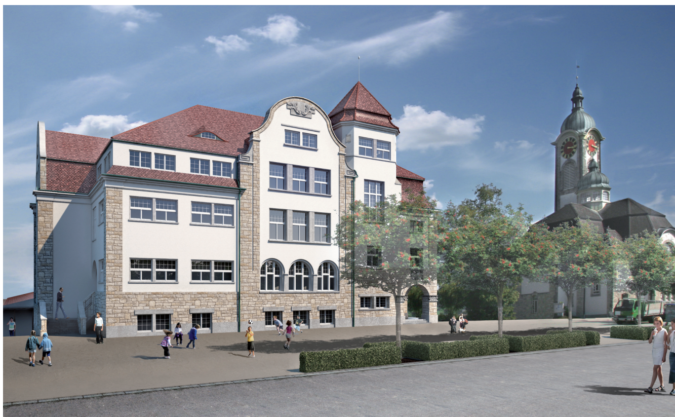
Mit der Rückführung der Westfassade in den ursprünglichen Zustand bilden Schulhaus und Kirche wieder ein stimmiges Ensemble.
