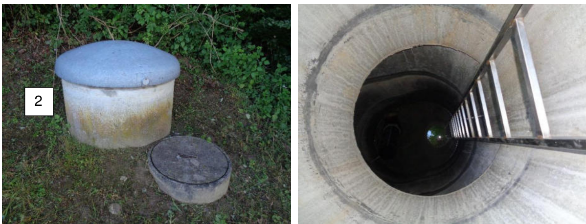
Abb. 4.5 und 4.6: Kontrollschacht 2 mit Spülschacht, Blick in Kontrollschacht 2 (Fotos L&H; 18.6.2020)
