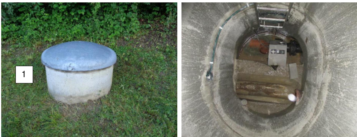
Abb. 4.3 und 4.4: Kontrollschacht 1, Blick in Kontrollschacht 1 mit Spüleleitungsklappe (Fotos L&H; 18.6.2020)
