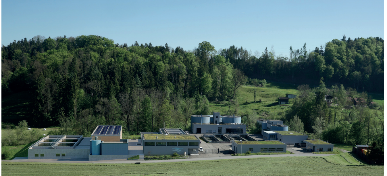
Visualisierung der ARA Oberglatt nach der geplanten Erweiterung der Biofiltration und der Mikroverunreinigungs-Stufe.
