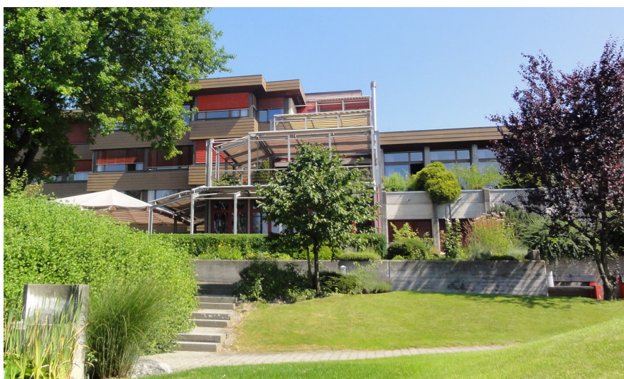
Beim Regionalen Pflegeheim sind keine Platzreserven für Erweiterungen vorhanden.
