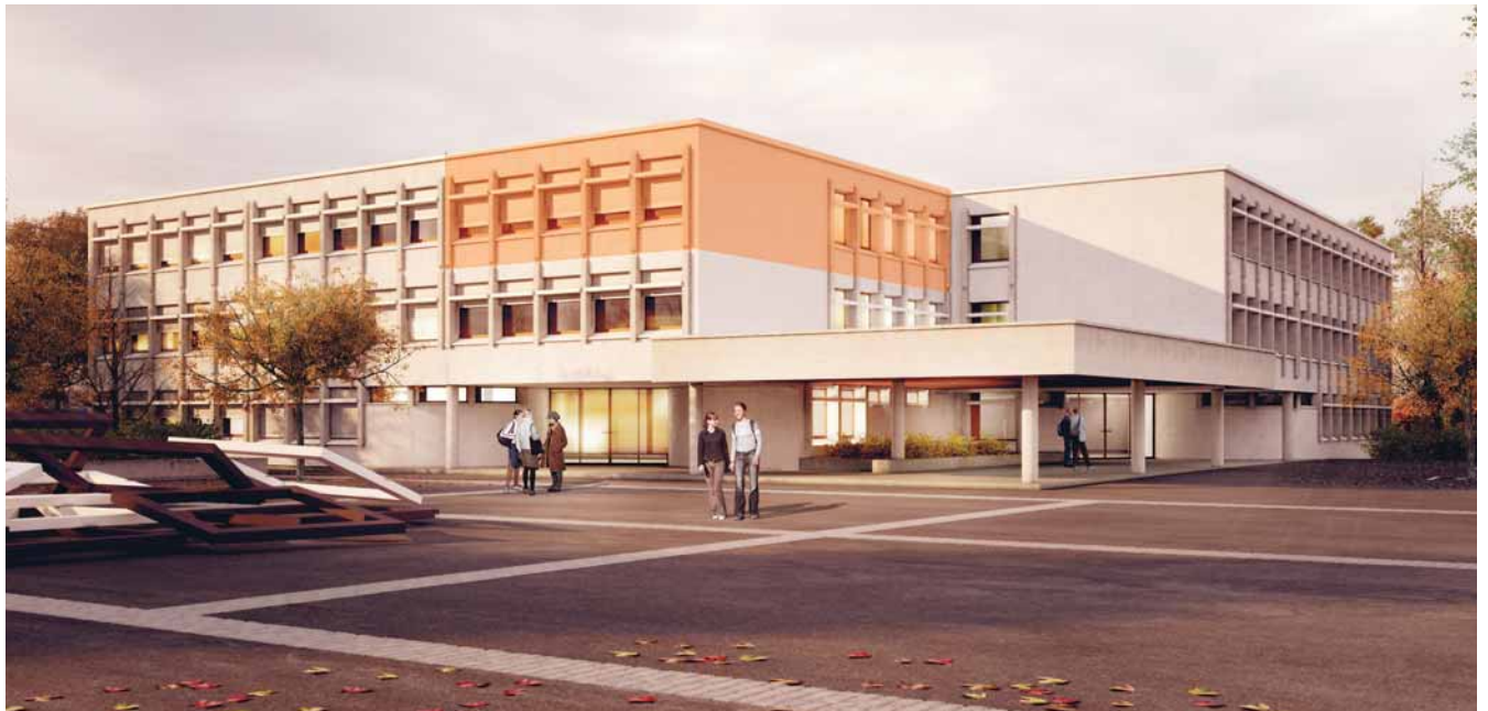
Aussenansicht des erweiterten Oberstufenzentrums (orange unterlegt = Neubauteil)
